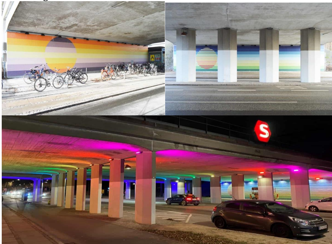
Sydhavn Port, Søren Hüttel, 2022. Tunnellen under Sjørlø Station, Københavns Kommune.
