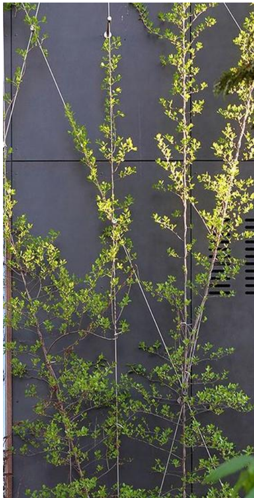
Grønvæg på syd facaden
