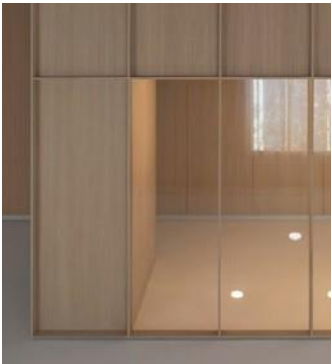
Indvendige vægge på fagkuberne udføres i perforeret krydsfiner og glas opdelt med trælist. Udvalgte områder anvendes akustikregulerende, andre skjuler tekniske installationer som radiatoer.
