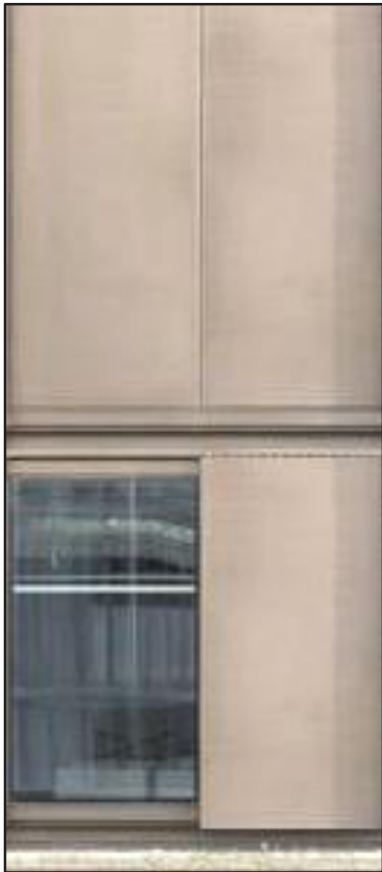
Den varme brune farve fra den anodiserede aluminium føres videre på de lukkede partier i glasfacaderne.
