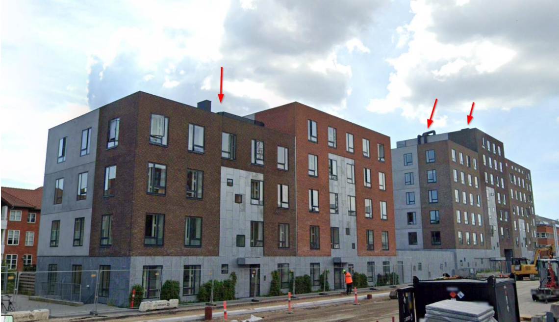
Herlev, Ring 3 ved Herlev Bymidte. Billede taget fra Google Streetview og ventilationsanlæg ses meget tydeligt, også fra andre vinkler. Kønt er det ikke. Kunne have været gemt under et saddeltag.
