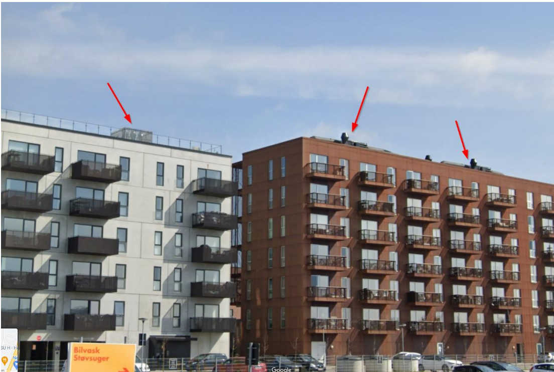
Herlev, Den Grønne Fatning. Billede fra google Streetview. Installationer på taget ses tydeligt på trods af at bygningerne er henholdsvis 6 og 7 etager. Kunne have været gemt under et saddeltag.
