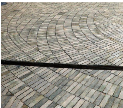
Teglbelægning med organisk formede forbandter.
